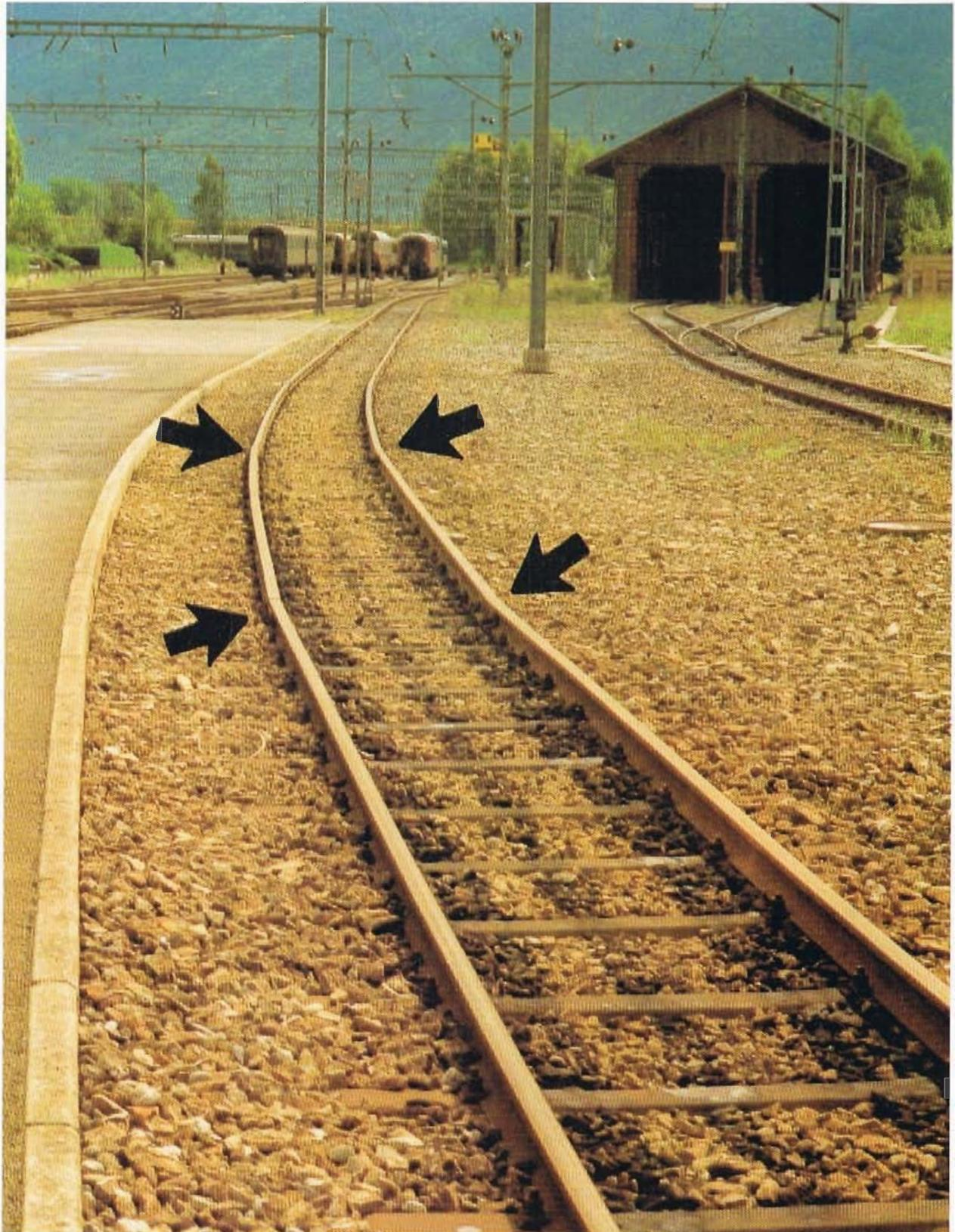
*La foto muestra un «mal ejemplo» de vía original: en la curva los raíles forman codos (ver flechas); un modelista no podría permitirse esto en su maqueta. Por supuesto, en el original (en este caso, una línea de vía estrecha en Suiza) tampoco se da con frecuencia, sino sólo en algunos tramos de circulación lenta y poco transitados.*
