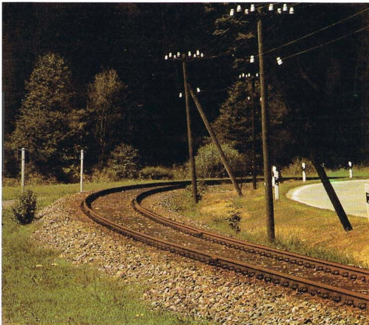
*En esta foto del original se puede ver todo aquello que es importante en la construcción de vías, desde el lecho de balasto bien construido hasta la configuración del terraplén pasando por los «elementos marginales», a los que también pertenecen los postes de telégrafos en las vías sin electrificar de la época 3.*
