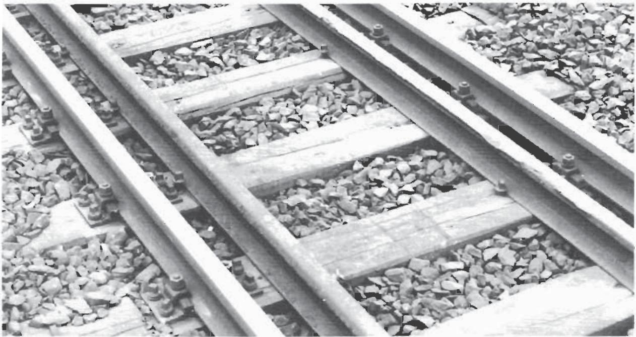
*Los raíles guía o el raíl de protección unilateral se instalan, entre otros casos, en viaductos, puentes y en vías que pasan muy cerca de pilares de puentes o edificios, o en las zonas críticas de curvas muy cerradas. Con ello se quieren evitar daños mayores en caso de un descarrilamiento.*
