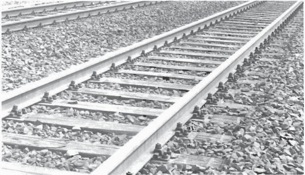
*Ejemplo original para una vía de ancho estándar en nuestra maqueta: una vía de 1.<sup>ª</sup> con perfil UIC 60 (correspondiente a unos 2.0 mm de altura en la escala H0).*
