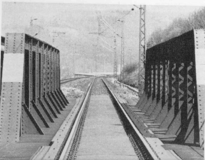
*Éste es el aspecto habitual que tienen las fijaciones y las cubiertas de las vías en un puente. Se pueden observar la fijación múltiple del perfil de los raíles, la cubierta de la entavía mediante placas de chapa y las cubiertas de rejillas a los lados. Foto: em.*
