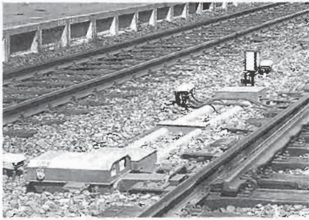
Figura 4.15 El motor de agujas de una pieza real.
