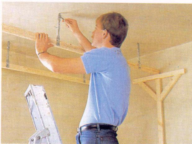
Un ejemplo de una maqueta ferroviaria colgante como la que se describió en lo relativo a la construcción y realización en el capítulo 8. En la foto: fijación de los listones para la cavidad bajo el techo en la que se integrará la maqueta. La fijación se realiza mediante tacos Fischer SB 8/8 (con tornillos de argolla de agujero largo); para cada uno de ellos, se precisa una perforación en el techo de 50 mm de profundidad.
